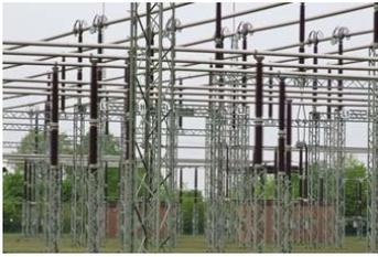
Zu den Umspannanlagen kommt der Strom über Hochspannungsleitungen. Dort angekommen wird der Strom so umgewandelt, dass er an die Häuser verteilt werden kann.
