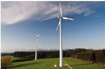
Windräder nutzen die Kraft des Windes, um Strom zu gewinnen. Der Wind treibt den Propeller eines Windrads an und eine Maschine, ein sogenannter Generator, erzeugt aus dieser Bewegung Strom. Je stärker der Wind bläst, desto mehr Strom wird gewonnen. Weil am Meer besonders starker Wind weht, gibt es dort besonders viele Windräder. Es gibt sogar **Windparks**, die vor der Küste, also im Meer stehen. Diese nennt man Offshore-Windparks. Offshore ist der englische Begriff für „vor der Küste“.
