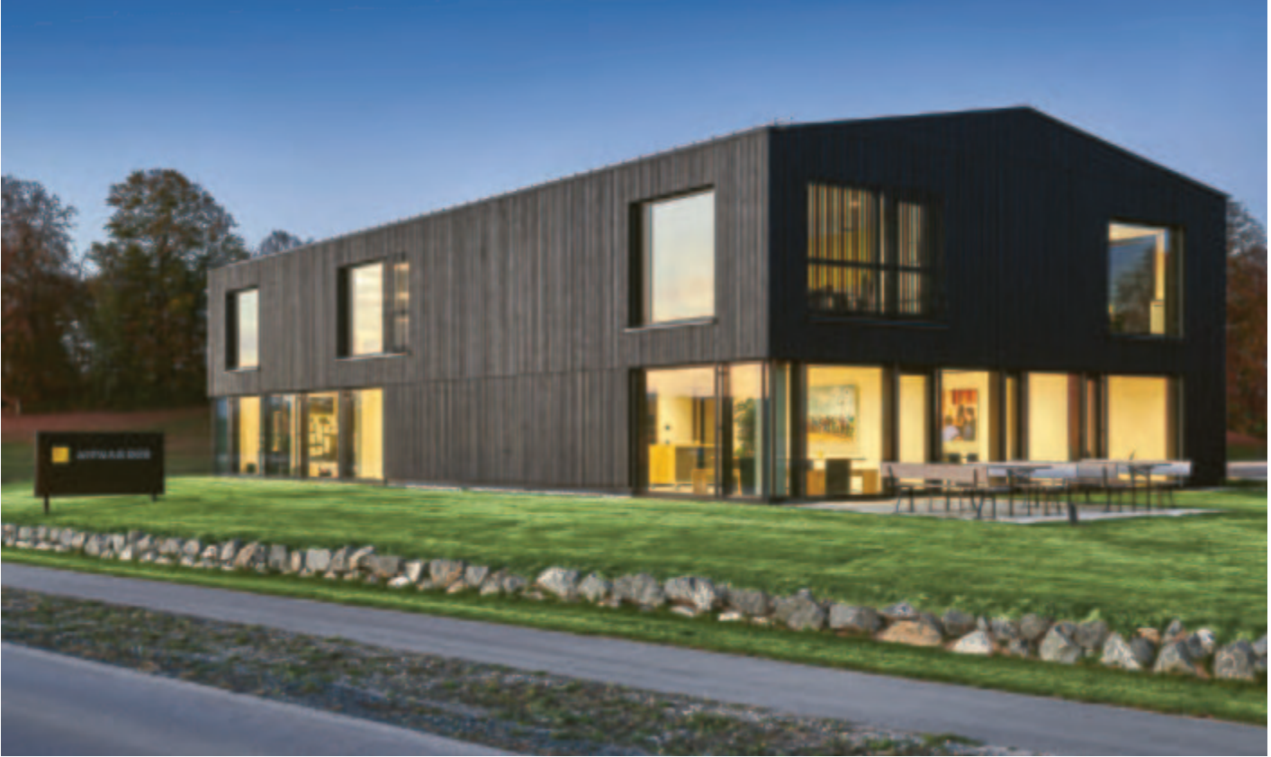
Zukunftssicher und nachhaltig Der Firmensitz von Anwander wurde nach neuen Energiekonzepten gebaut
